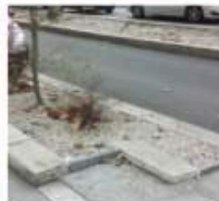
Bordures anciennes recyclées ( Cours Barriat )
