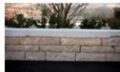
Solution blocs éclatés et couverture en croule ( Epode , 2007)
